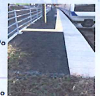
新白河駅6番線ホームかさ上げの様子
